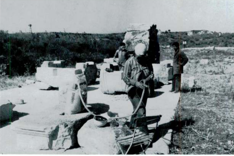
Res. 19 - Demetrios-Apollonios Takı onarım alıřmalarından bir grnm. F-L sıralarına iliřkin tařların kum pskrtme yntemiyle temizlenmesi.
