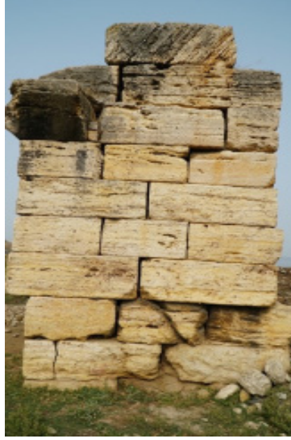
Resim 13: Asopos Kprüsü'nün ayakta kalabilen doęu ayaęının korniiŐyle kuzeyden grnm, duvar rg sistemi ile blok aŐınmaları.
