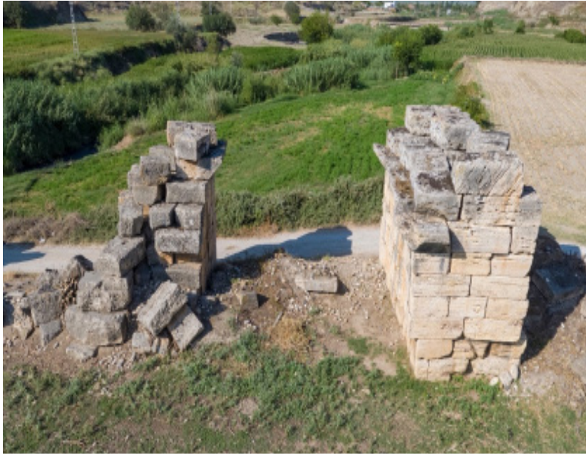
Resim 15: Asopos Köprüsü doğu kemer ayakları alanının bitki temizliği sonrası durumu.
