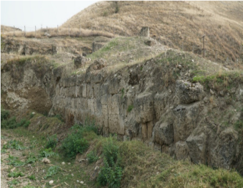
Resim 8: Asopos Köprüsü'nün doğu yakası masif kuzey istinat duvarları.
