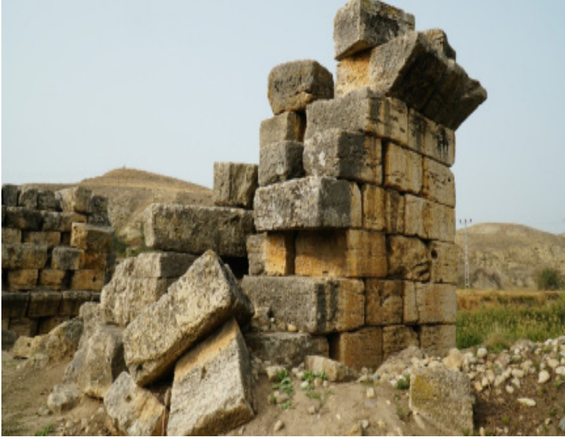
Resim 11: Asopos Köprüsü'nün ayakta kalabilen doğu ayağı ve ayaktaki açılmalar, yıkıntılar ile örgü sisteminin genel görünümü.
