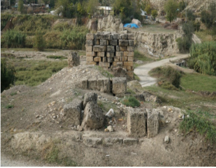
Resim 7: Asopos Köprüsü'nün doğu yakası istinat duvarları ve iç kısımlarında belirli aralıklarla yapılan merdiven basamağı şeklinde sandık tipli yapılan duvar sağlamlaştırma bağlantıları.
