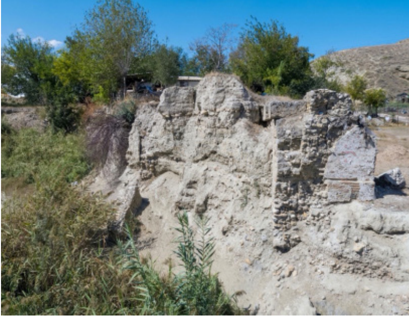
Resim 21: Asopos Kprs'nn batı uzantısında tahrip ve heyelan sonunda kalabilen opus caementicium istinat duvarları, yol dŐemesi ile kuzeyde bitiŐik freskli-tonozlu mezar kalıntısı.
