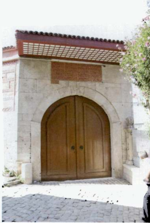
Resim 5. Ayasofya İmaretı, Batı Cephede Bulunan Avlu Kapısı.
