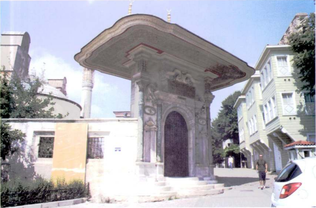
Resim 3. Ayasofya İmaretî, Avlu Taçkapısı, Meydana Bakan Cephe.
