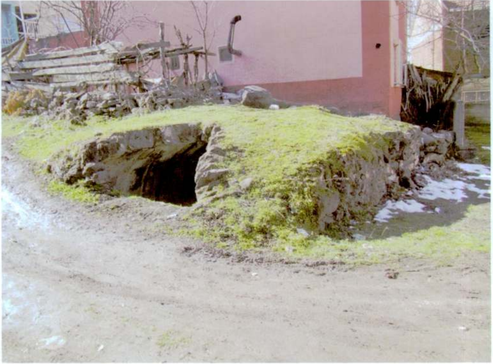
Resim 45- Kùltür Mahallesi'ndeki yapı, 2012.
