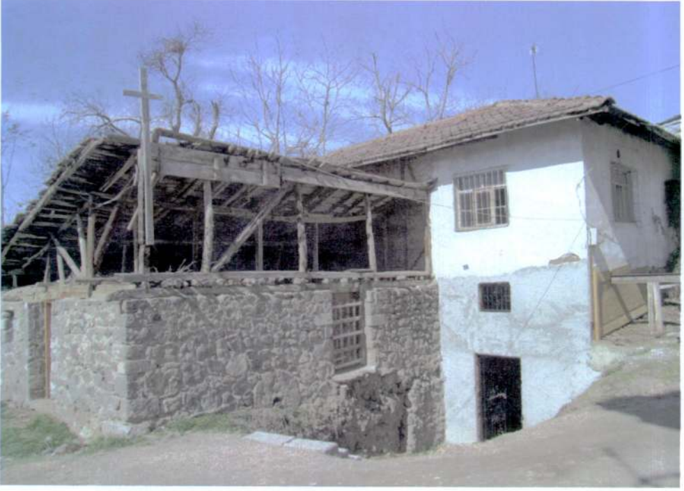
Resim 15- Evlerin altında kalan alt yapının girişi, 2012.
