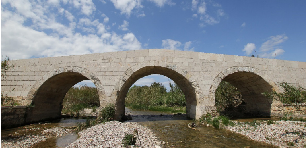
Resim 5: Köprünün restorasyon sonrası genel görünümü, güneyden.
