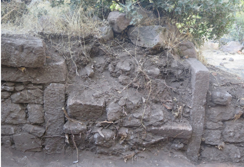
Resim 18: Got Akımı sebebiyle örülerek iptal edilmiş kapı
