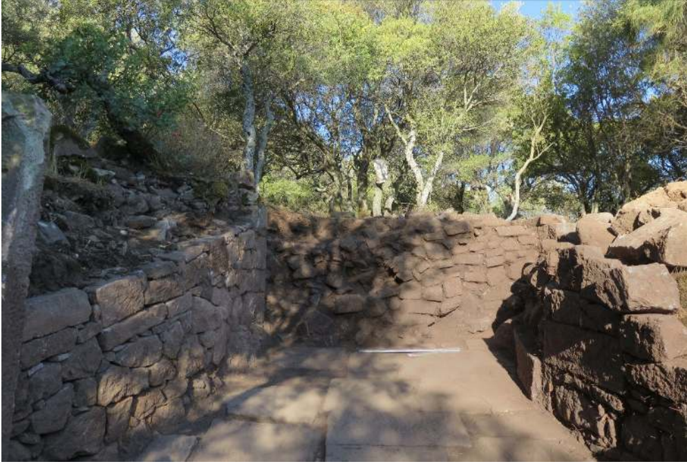
Resim 22: Athena Caddesi'ni kapatan MS 6. yüzyıl duvarı
