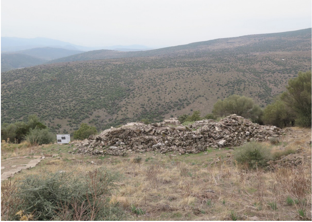
Resim 15: Tiyatro sahne binası enkazı
