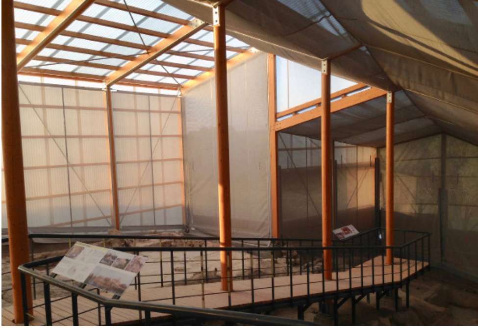
Fig. 3: Höyüğün güneyindeki MÖ 8. bin yıl ‘özel amaçlı yapılar’ı korumak amacıyla yapılmış koruyucu çatı yapısı, içeriden görünüm.
